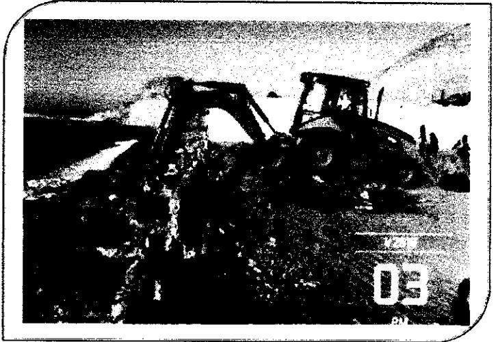
FOTO 04: Se realizó la Demolición de Construcción de Albañilería Confinado, en Zona de Descarga, Sector N°03.
