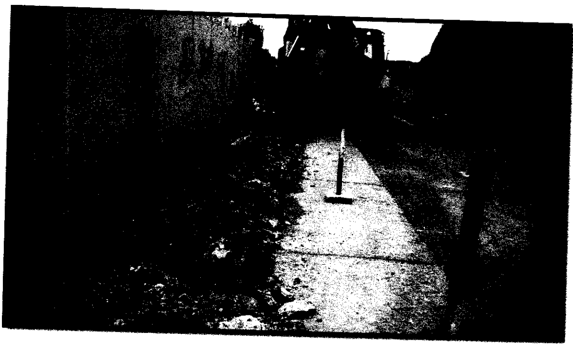
ILUSTRACIÓN 5: DEMOLICIÓN DE VEREDAS.
