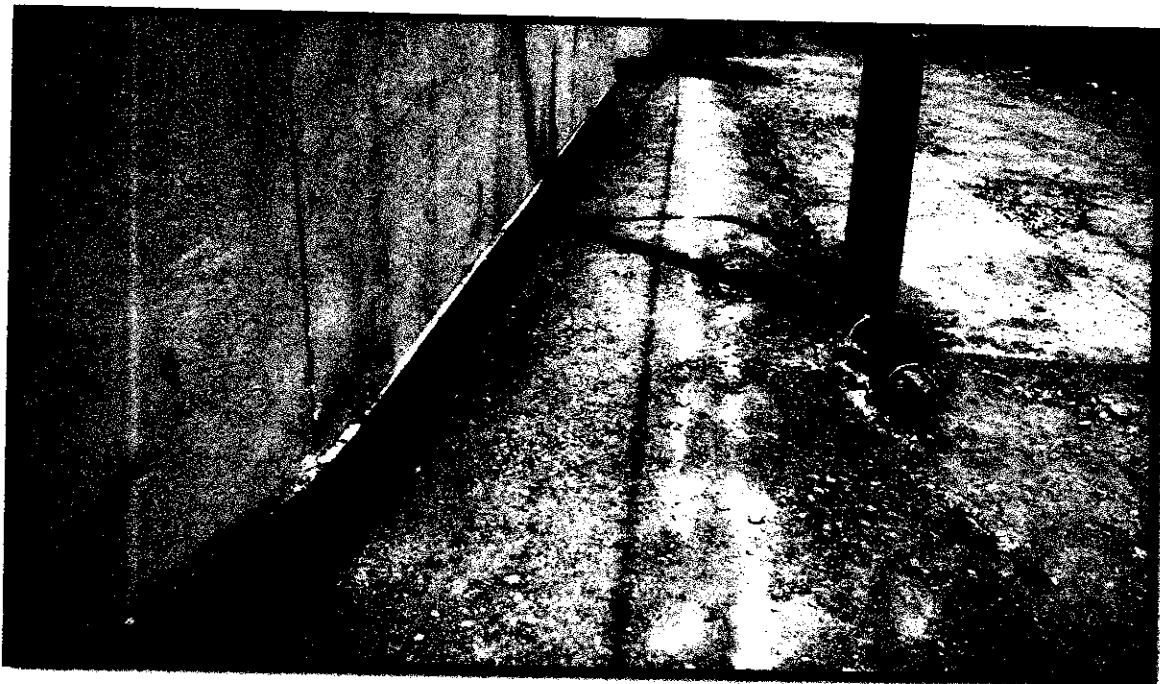
ILUSTRACIÓN 15: TRAZO Y REPLANTEO DE VEREDAS (SECTOR 2)
